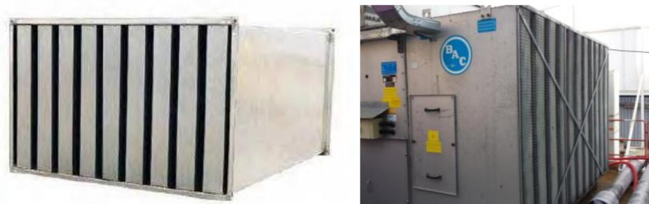
Exemples de pièges à son en sortie de rejet d'air
