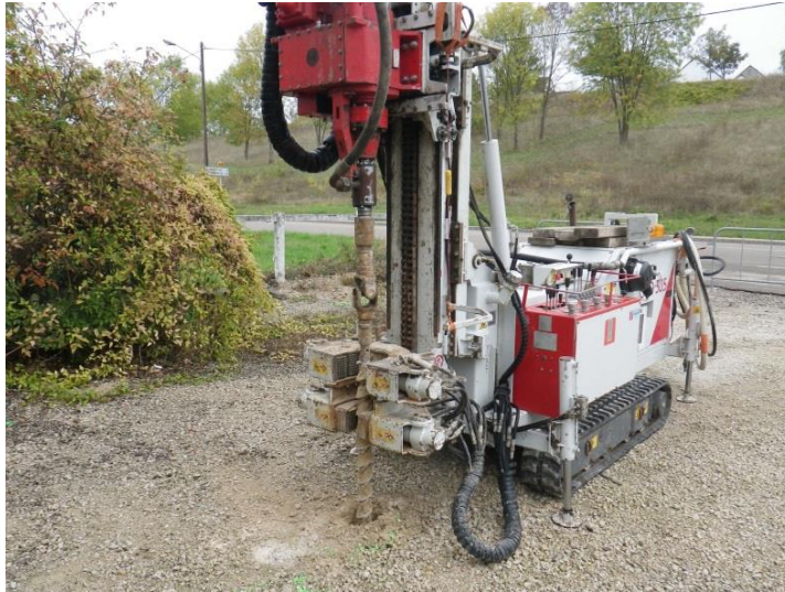
Réalisation de sondage de sols
